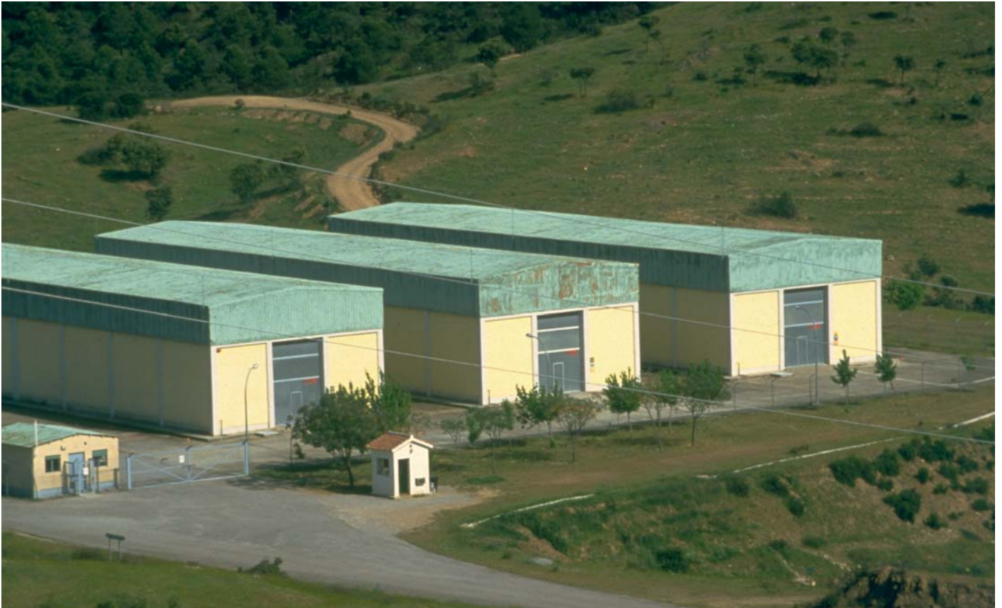
Antiguos módulos de almacenamiento en El Cabril (Hornachuelos, Córdoba).
