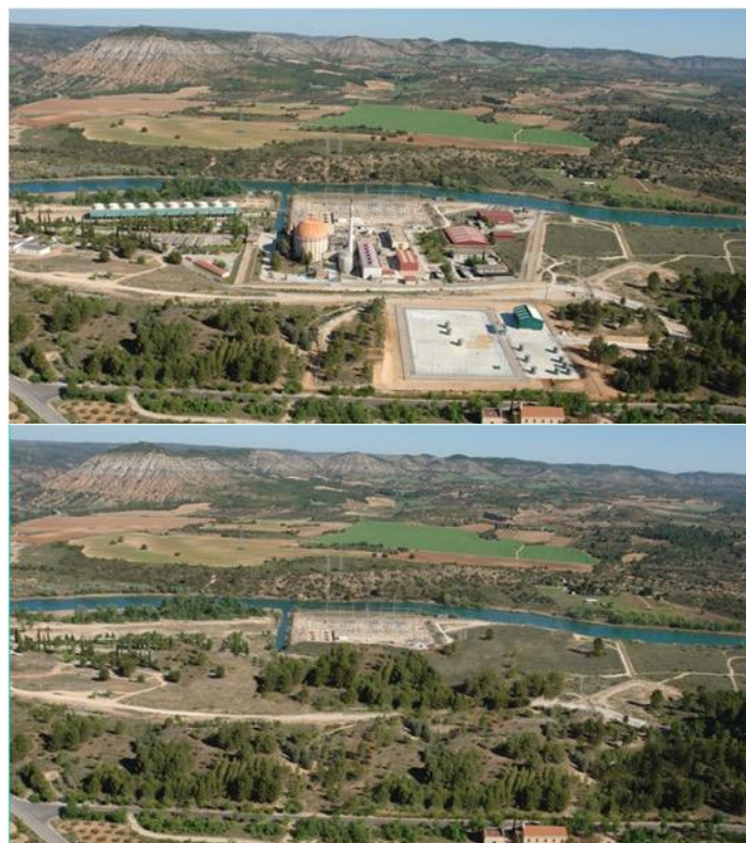
Figura 3-23: Emplazamiento de la CN José Cabrera antes y después del desmantelamiento y restauración de los terrenos
