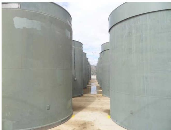
Figura 4-4: Vista general del ATI de la central nuclear José Cabrera
