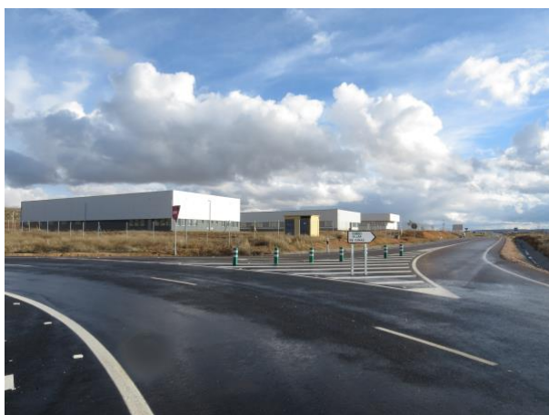
Figura 4-9: Vivero de Empresas con el Laboratorio Conjunto y Nave Auxiliar
