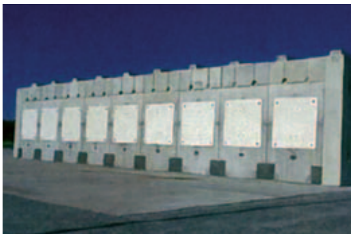
Figura 8. Instalación de almacenamiento temporal en nichos. A la derecha, introducción de un contenedor.
