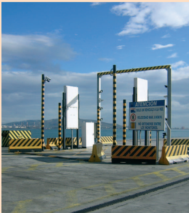
Portal de detección radiológica en un puerto.
