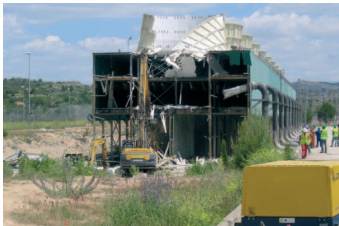
Derribo de las torres de refrigeración de la central José Cabrera.
