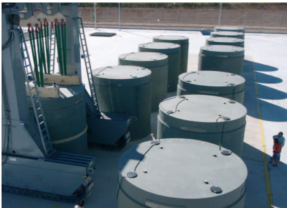
Figura 6. Colocación del último módulo de almacenamiento en seco de combustible gastado en el almacén temporal de la central nuclear José Cabrera.
