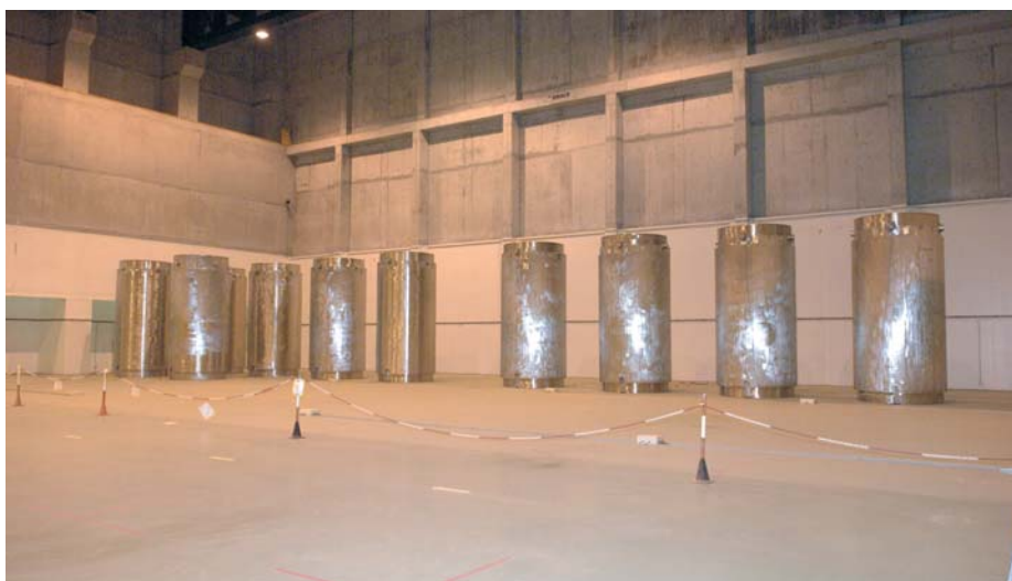
Contenedores de combustible gastado en el Almacén Temporal de la central de Trillo.
