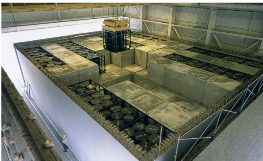
Almacenamiento de un contenedor en una celda de El Cabril.
