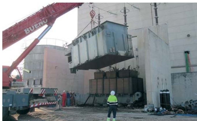
Desmontaje del transformador principal de la central José Cabrera.
