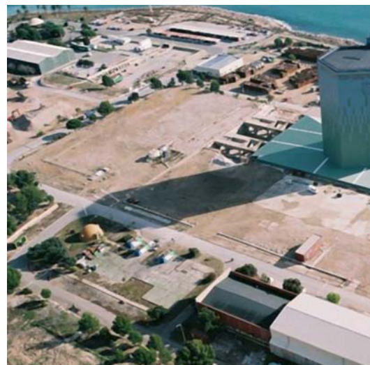
La central de Vandellós I, en la actualidad.
