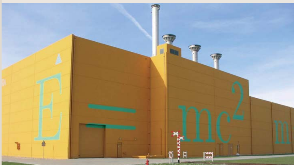
Panorámica de la instalación HABOG, el Almacén Temporal Centralizado de Holanda.
