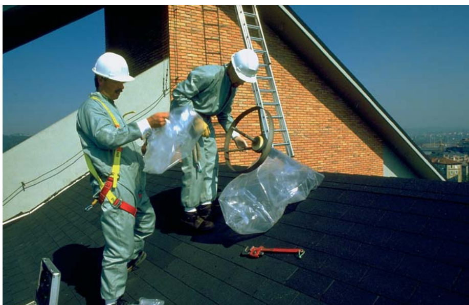
Retirada de pararrayos radiactivos.
