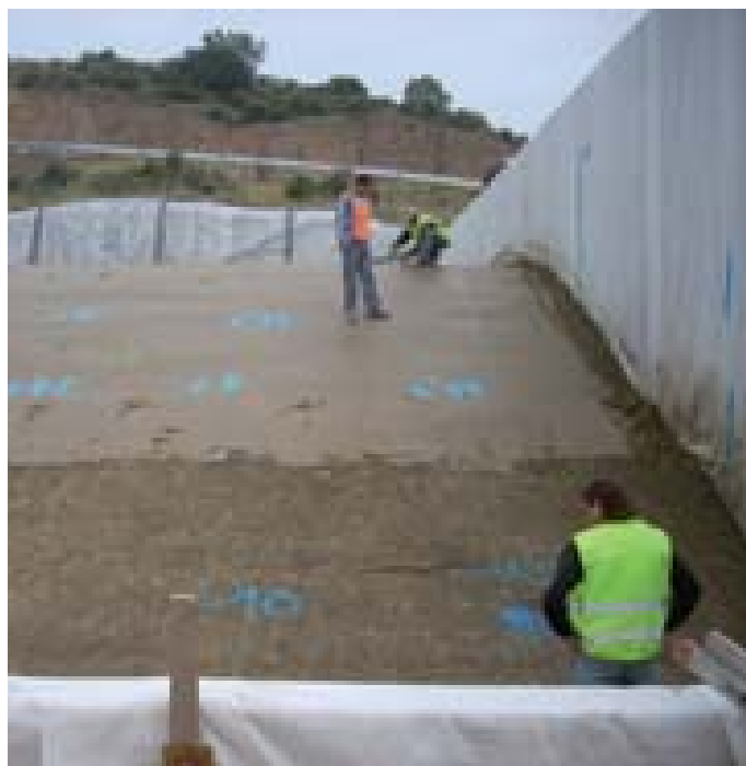
Tareas de construcción de las coberturas de ensayo en el almacén centralizado de residuos de baja y media actividad de El Cabril.
