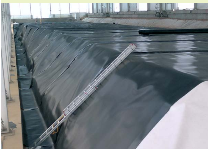
Colocación de la lámina de polietileno de alta densidad.
