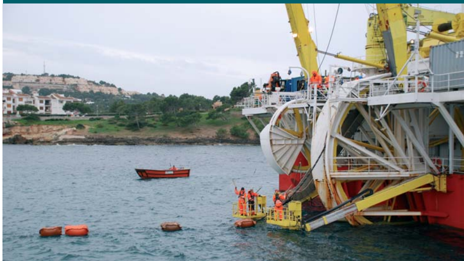
Varios operarios depositan el cable sobre flotadores desde la popa del Skagerrak .
