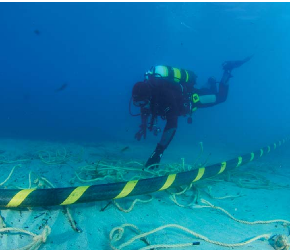
Un buzo realiza trabajos en el fondo submarino para la salida del cable a tierra, en Santa Ponsa (Mallorca).
