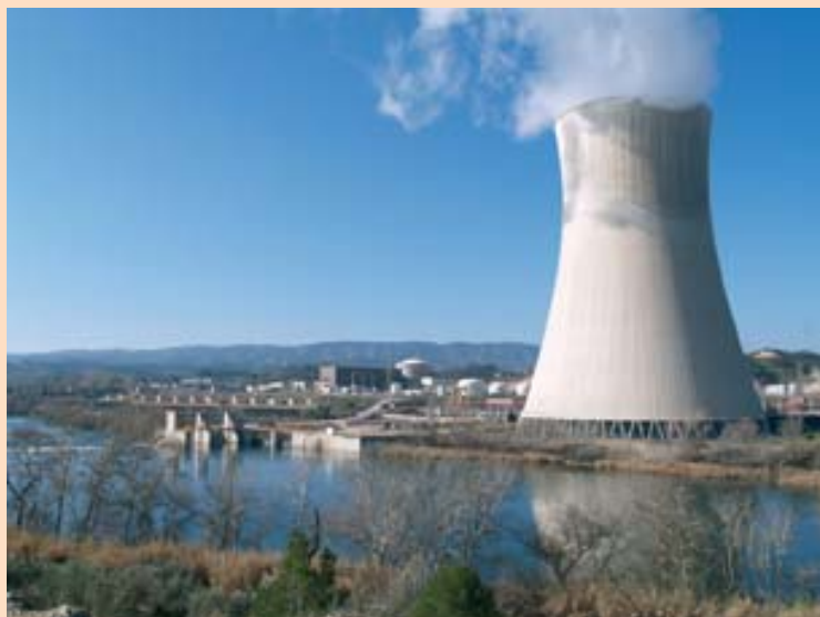
Panorámica de la central nuclear de Ascó.
