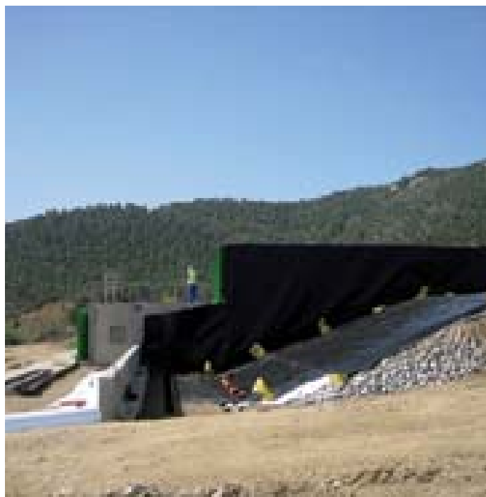
Tareas de construcción de las coberturas de ensayo en el almacén centralizado de residuos de baja y media actividad de El Cabril.
