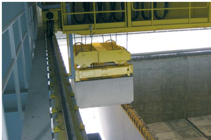
Un contenedor CE-2b es introducido en una celda.
