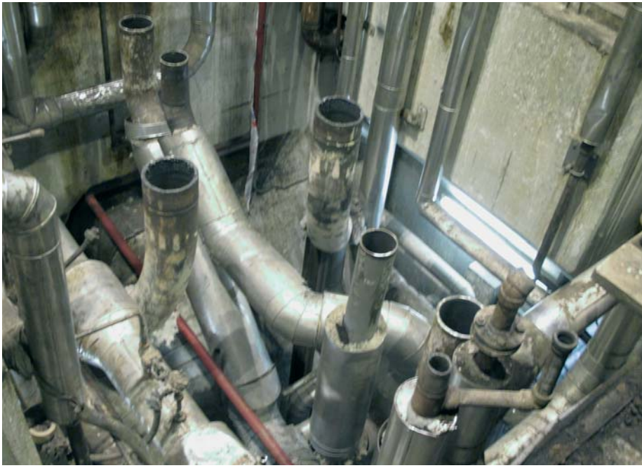
Zona de tuberías en fase de desmantelamiento.
