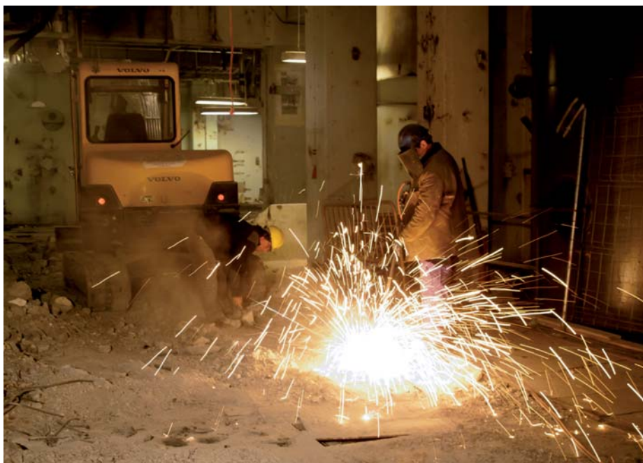
Trabajos de corte en el desmantelamiento de la central.
