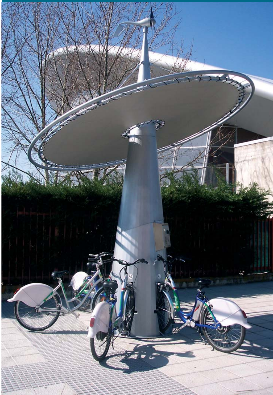
Las bicicletas eléctricas que ofrece Bicisol se recargan mediante paneles solares y aerogeneradores.
