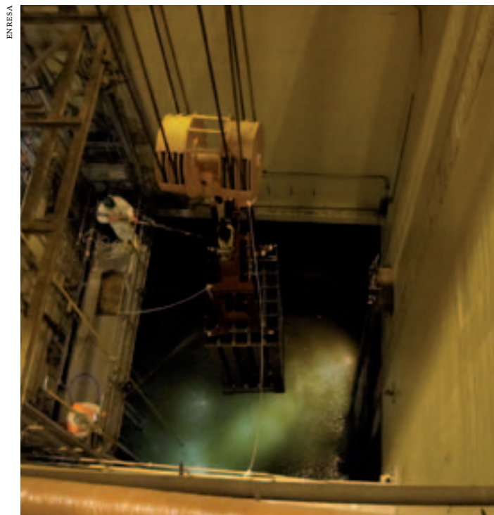
Extracción de racks de la piscina de la central nuclear José Cabrera.
