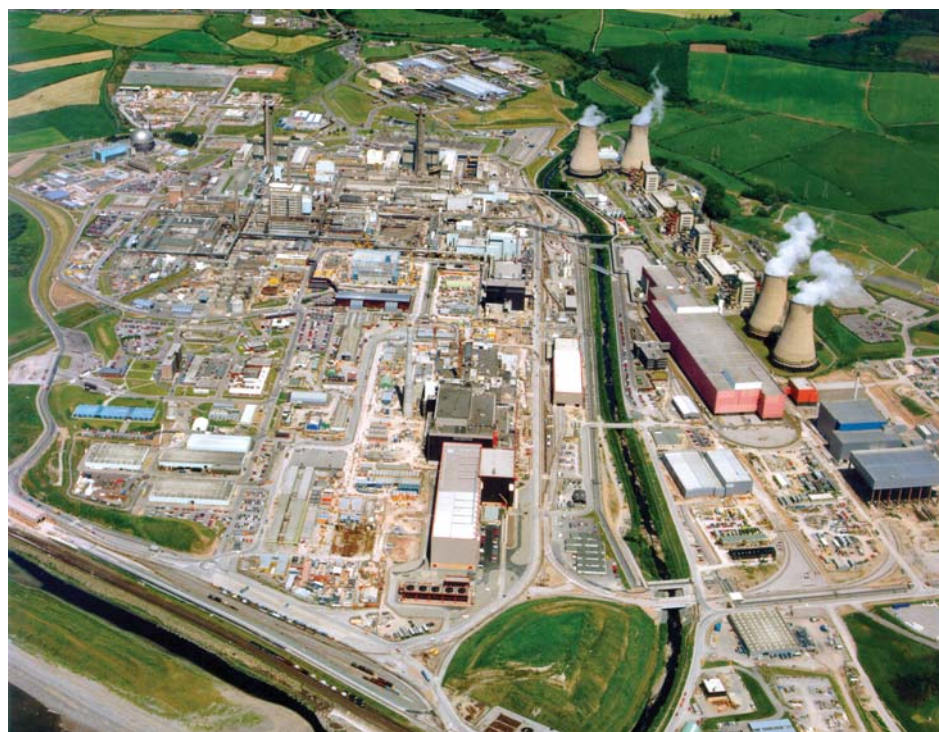
El complejo de Sellafield, que se encuentra en Reino Unido, alberga dos plantas de reprocesado de combustible y un reactor nuclear, entre otras instalaciones.
