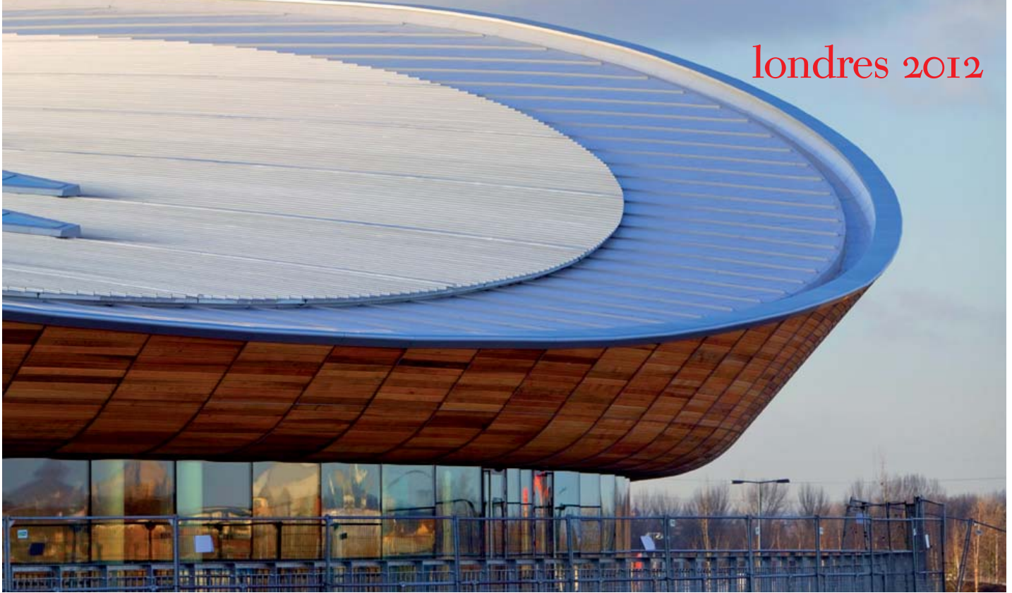
En la página anterior, dos vistas del Estadio Olímpico; exterior del Basketball Arena e interior del edificio de las piscinas olímpicas y del velódromo. La cubierta de esta última construcción, sobre estas líneas, está concebida con criterios bioclimáticos.
