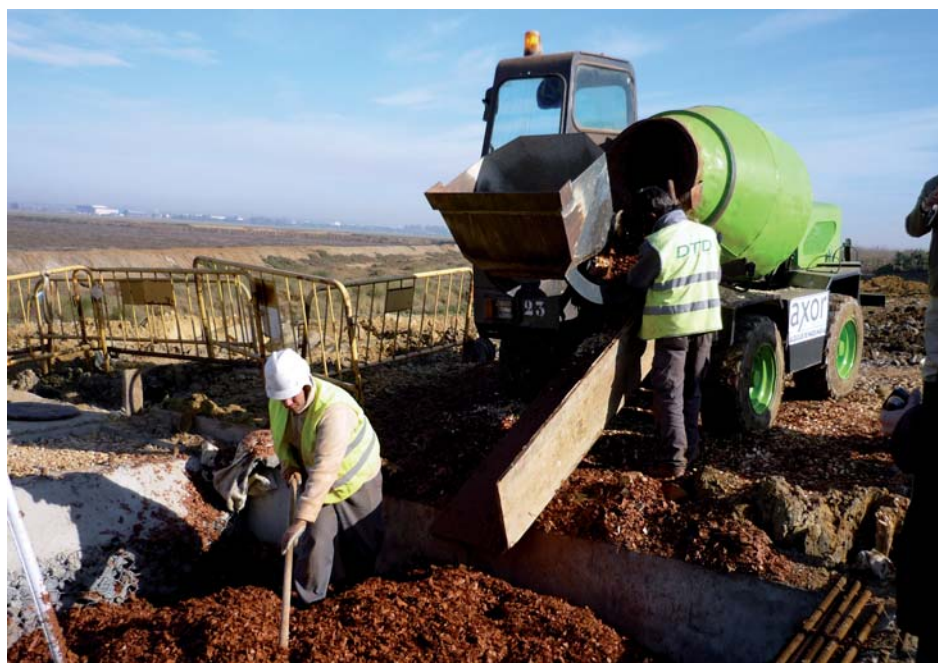
Figura 4. Aspecto de la arcilla mezclada con virutas de madera.
