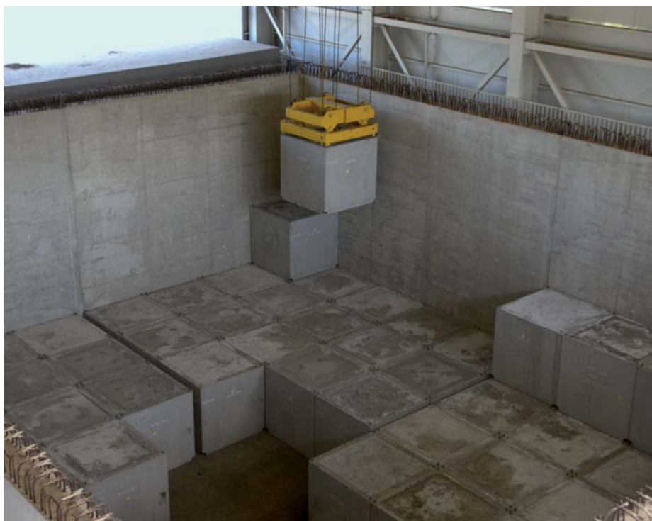
Colocación de contenedores en una de las estructuras de almacenamiento de la instalación.
