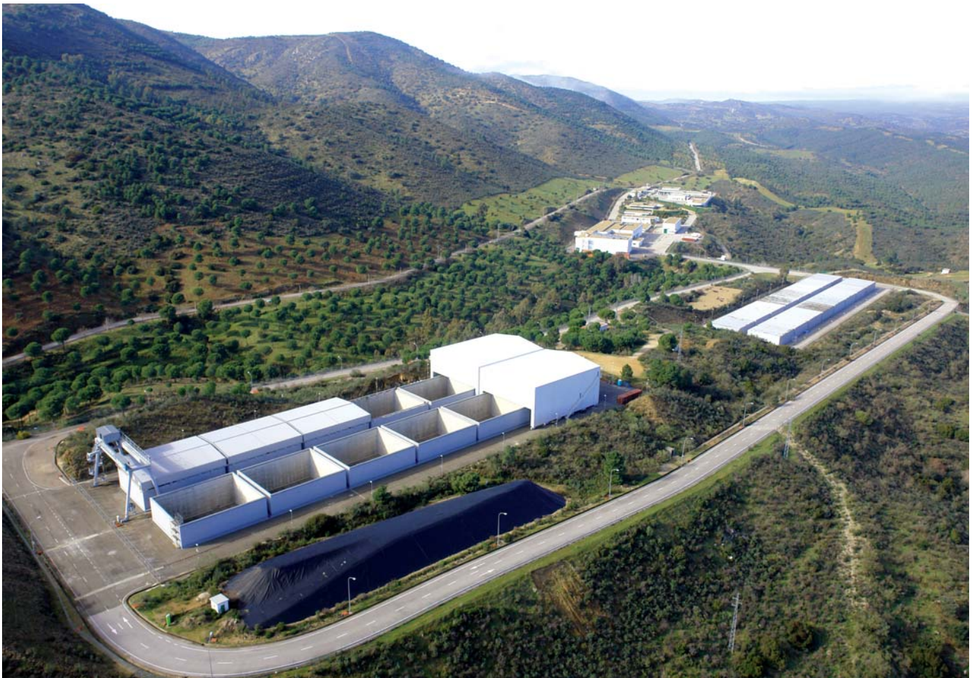
Panorámica de la instalación, con la plataforma norte en primer plano.
